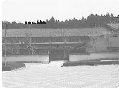
七尾市武道館
